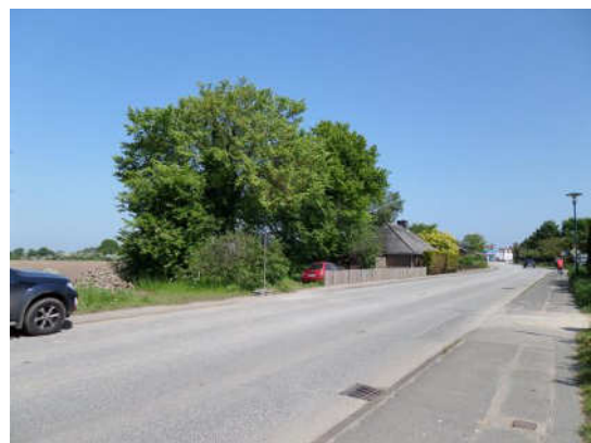
Bebauung östlich der Baulücke
