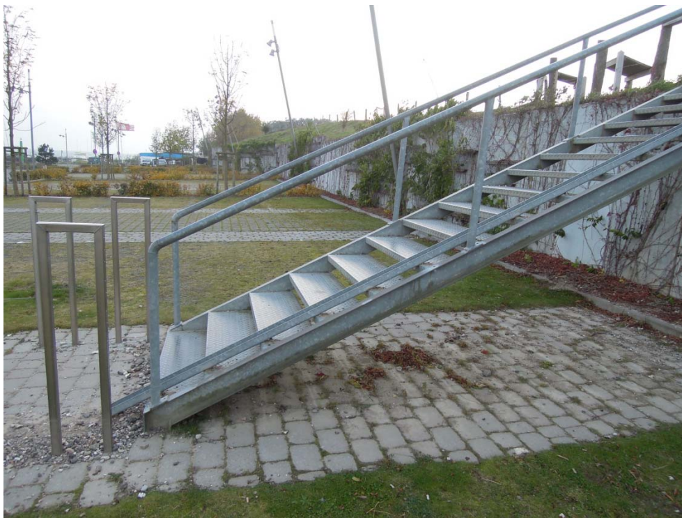
Abb. 15: Parkplatz am Jachthafen, Böschung mit Beton abgestützt
