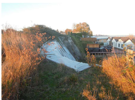
Abbildung 18: Blick auf den Hang Böschung, eigenes Foto vom 24.10.2024
