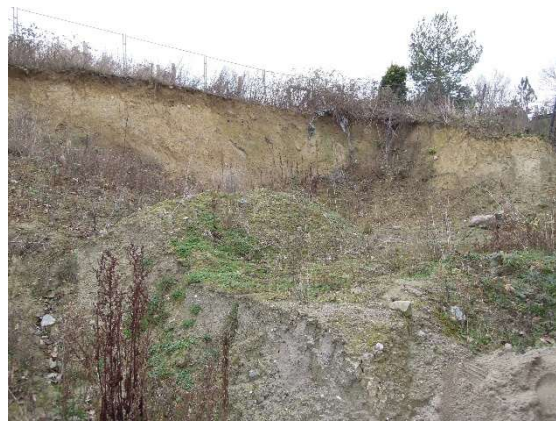
Abbildung 21: Abgerutschter Böschungsbereich unterhalb des Wanderweges, eigenes Foto vom 23.01.2020
