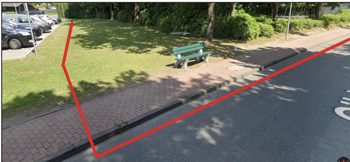
Trassenversprung in die Gildestraße, Verlauf an der nördl. Bordsteinkante
